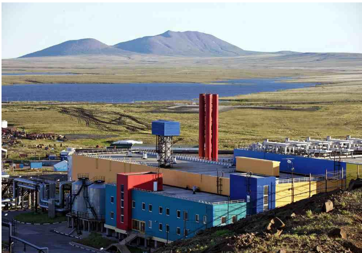
Рисунок 1-4. Общий вид Анадырской газомоторной ТЭЦ
